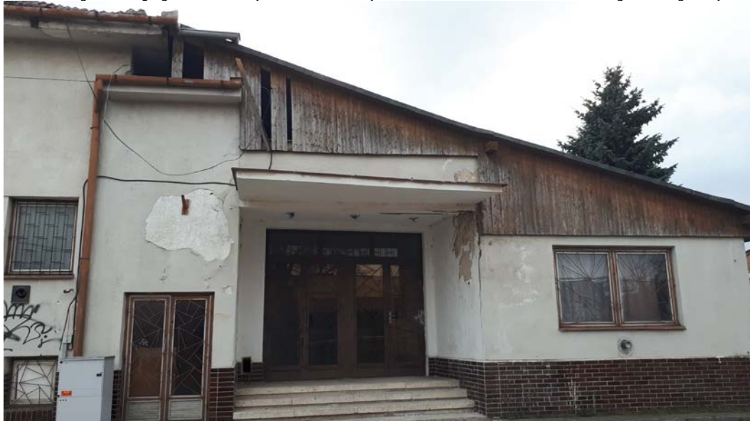
obr. 5-6 : Prestrešenie prístavby [1]
