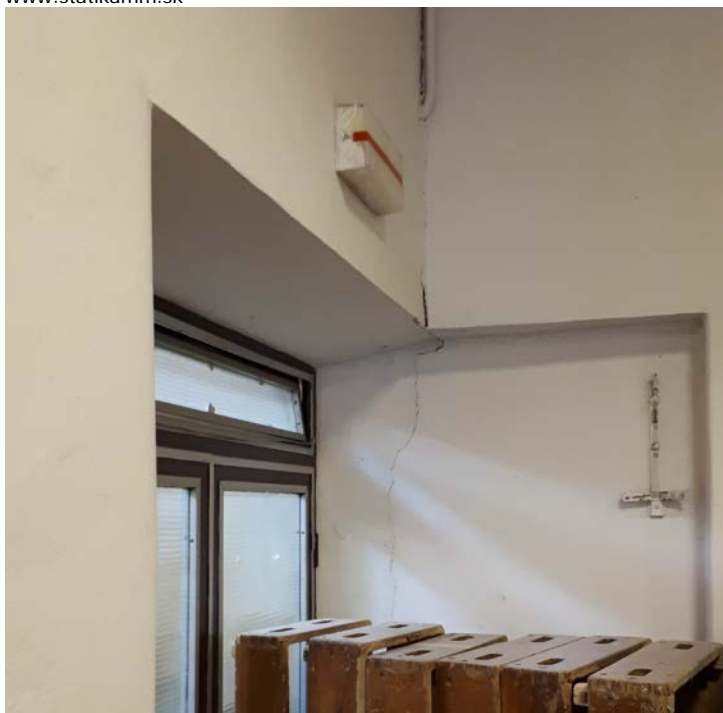
obr. 8-22 : Miesto styku centrálneho traktu a pôvodnej stavby [1]
